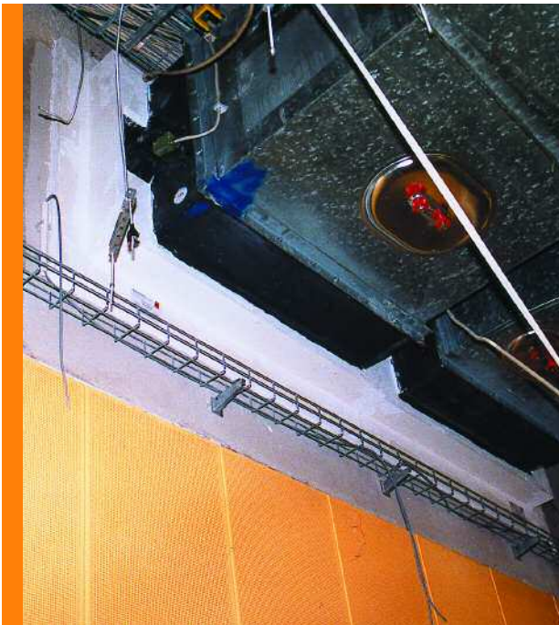
Brandschutztechnische Sanierung von Brandschutzklappen Reconstruction of fire protection shutters
