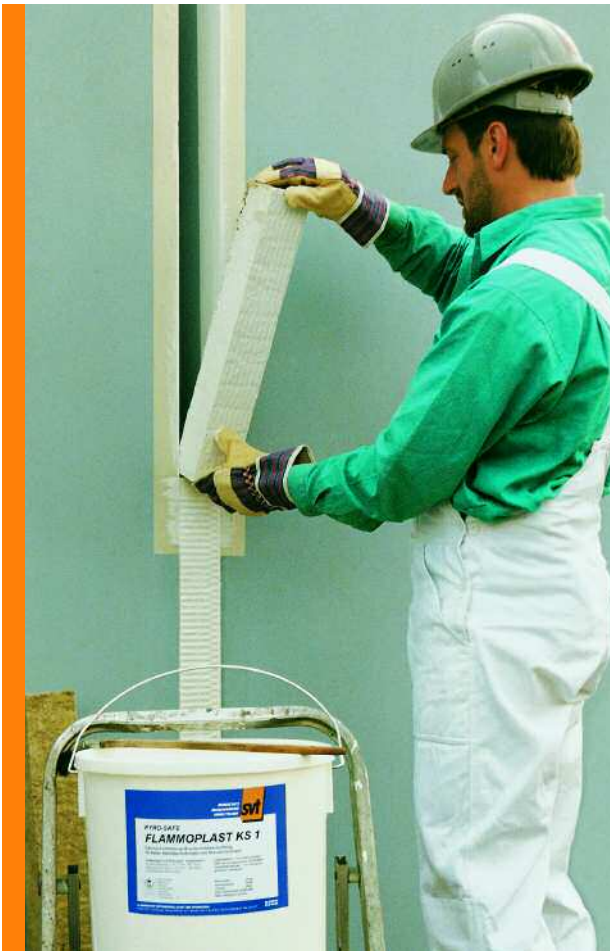
Montage einer PYRO-SAFE Fugendichtung in eine Bauwerksfuge Installing PYRO-SAFE Joint Sealings in a building component joint
