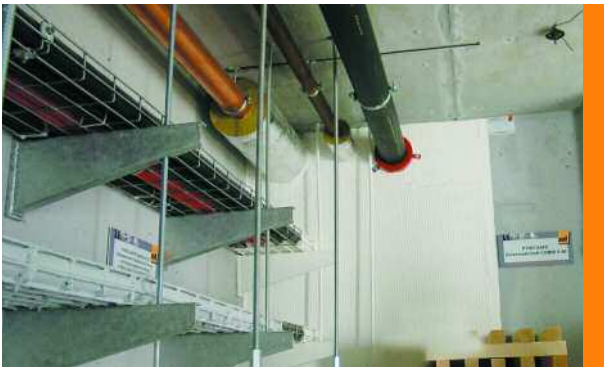
PYRO-SAFE Universalschott COMBI S90 als Wandschott PYRO-SAFE Universal Bulkhead COMBI S90 as a wall penetration seal
